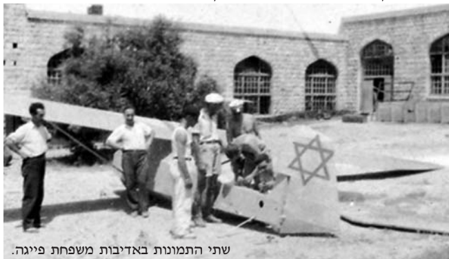
הרכבת דאון גרונאו ביבי על-ידי חברי קבוצת הדואים מגרמניה בחיפה.
